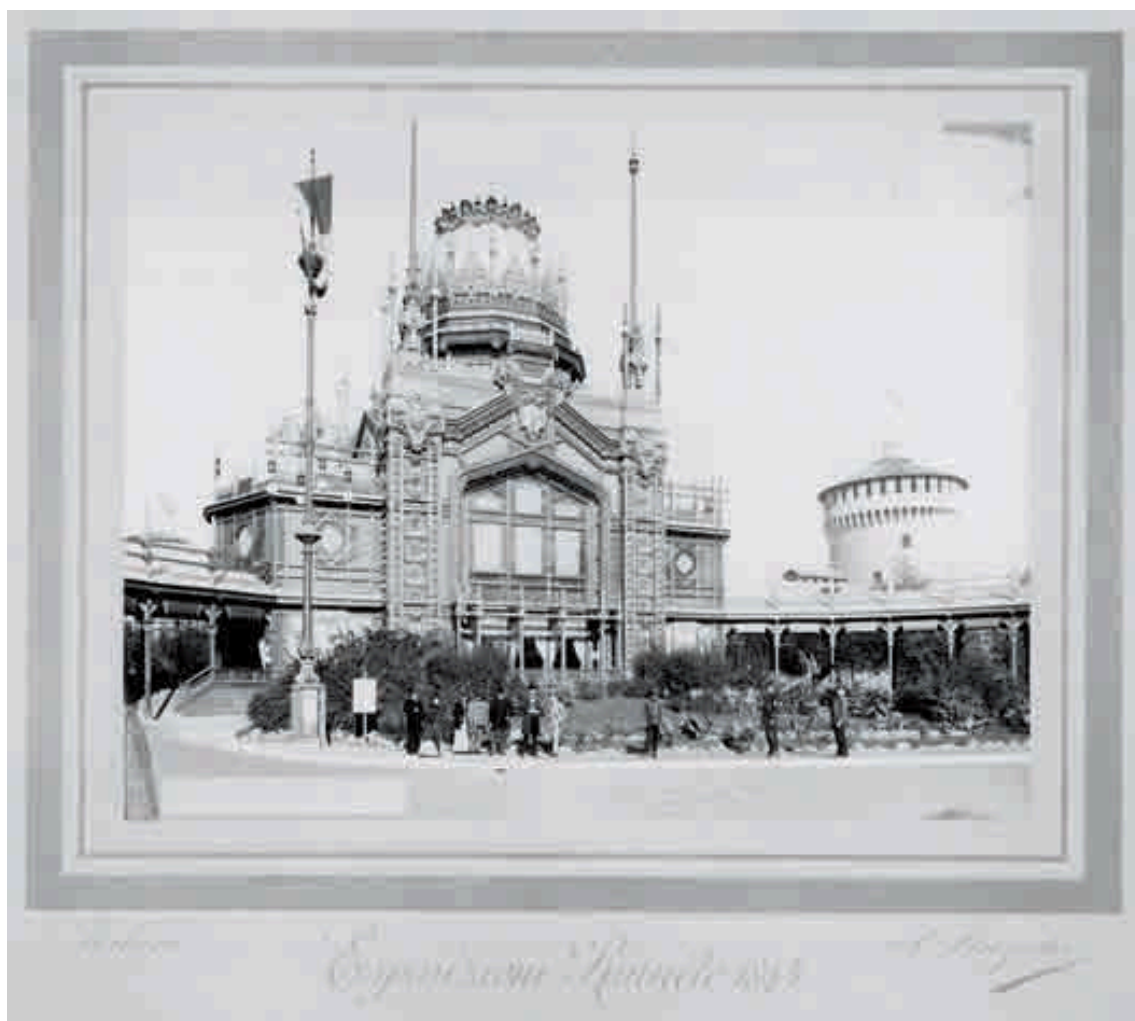
Chizzolini, Facciata dell'architettura d'ingresso delle Esposizioni Riunite, 1894. Milano, Civico Archivio Fotografico, Collezione Lamberto Vitali.
